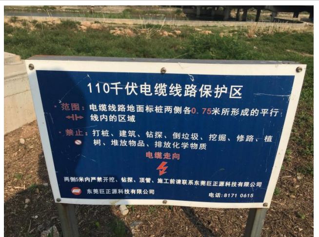
110kV 电缆线路标志牌
